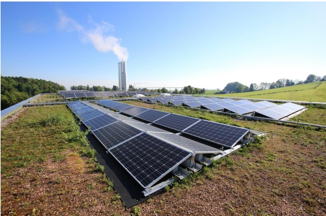
Liefern Erkenntnisse zur optimalen Unterkonstruktion auf Gründächern: Die acht unterschiedlichen Konfigurationen der Dachanlage.
